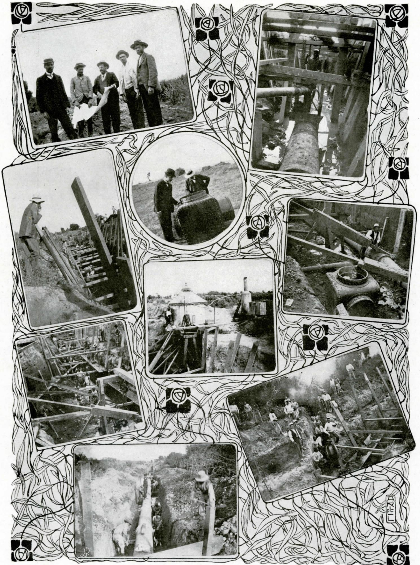
Obras de agua potable en el Callao
